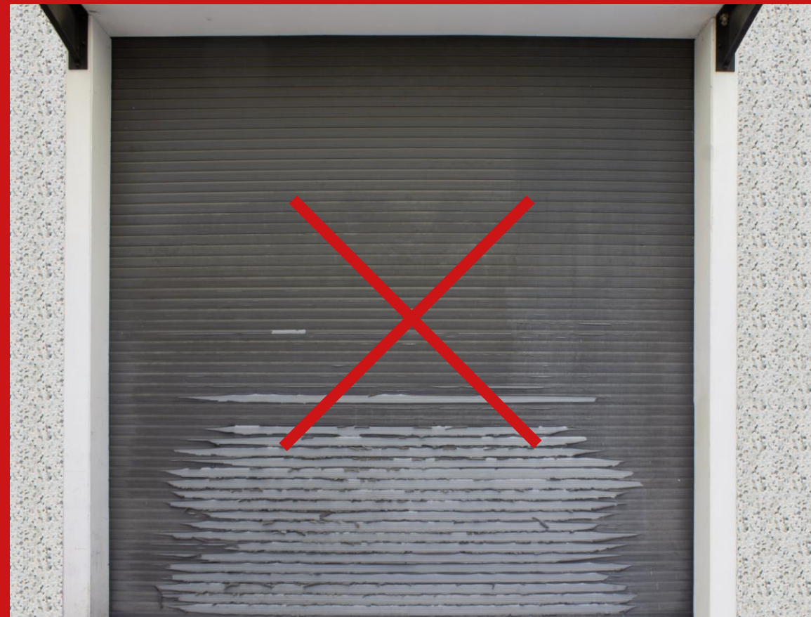
Serranda in acciaio rivestita in PVC esposta alle intemperie
